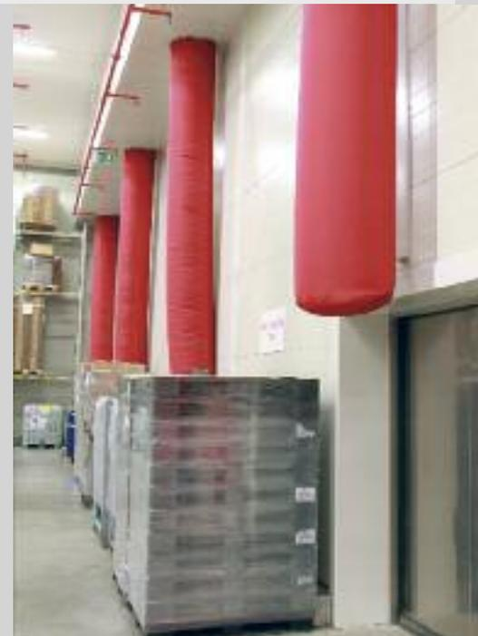
Über die roten Schläuche im Inneren der Kühlhäuser erfolgt eine gleichmäßige Abgabe der kalten Luft ohne Luftverwirbelungen.
